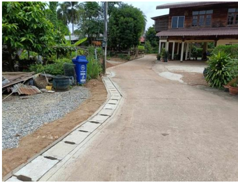
โครงการก่อสร้างรางระบายน้ำคอนกรีตเสริมเหล็ก ซอยบ้านนายส่ง จรรยา หมู่ที่ 5 บ้านนาทะเล
